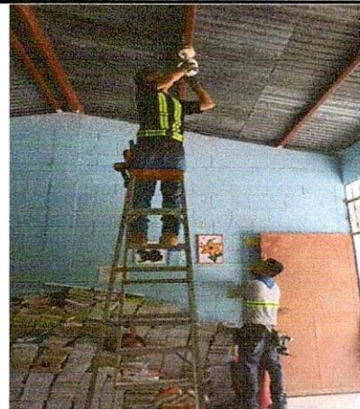
Foto 4: MEJORAMIENTO Y REPARACIÓN DEL SISTEMA ELECTRICO
