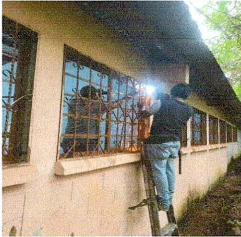
Foto1: MEJORAMIENTO DE VENTANAS
