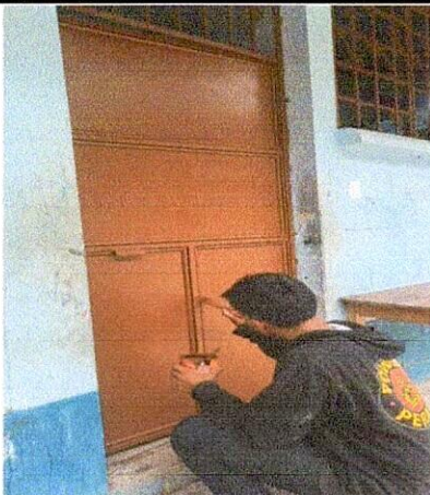
Foto 3: PINTURA EN PUERTAS
